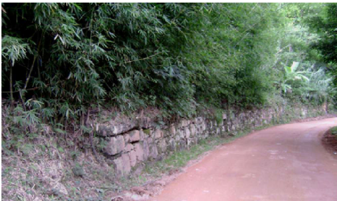
Figura 1: Muro de pedra, em trecho da Variante do Proença, próximo a Sebollas. Paraíba do Sul – RJ. Fonte: foto da autora.
