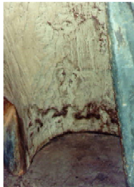
Figura 7 e 8: Eflorescência salina presente na parede e detalhe da mancha de umidade presente na região posterior da escultura.
