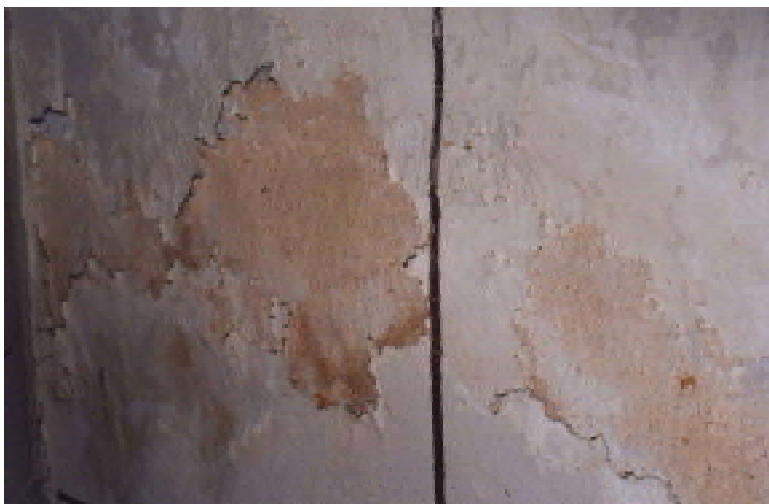
Figura 7 e 8: Eflorescência salina presente na parede e detalhe da mancha de umidade presente na região posterior da escultura.
