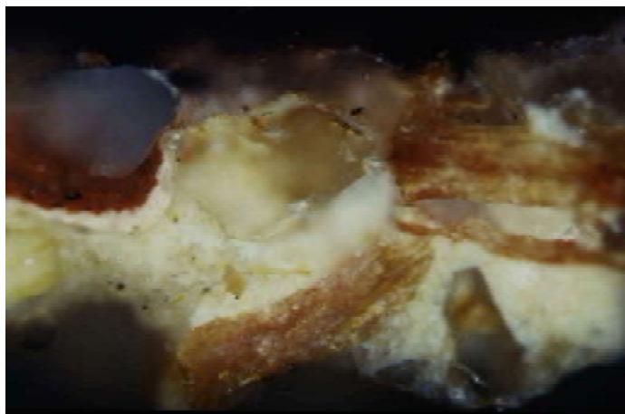
Figura 6: Degradação da argamassa. Foto: Lucienne Elias.
