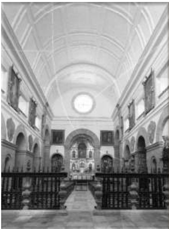
Figura 1: A Igreja. Fonte: Espanca (1996).
