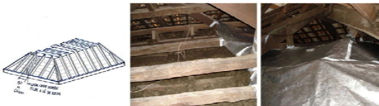
Figura 2: Desenho esquemático do forro do Salão Nobre e detalhe da colocação da lã de rocha sobre o forro e da manta contínua de Tyvek. Desenho e fotos da autora.
