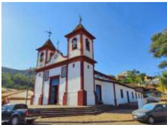
Figura 1A – Igreja Matriz de Nossa Senhora da Conceição. Sabará/MG
