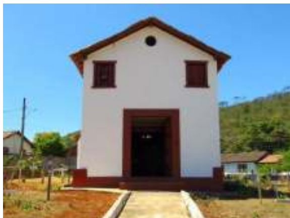
Figura 1B – Capela de Santo Antônio de Pompéu. Sabará/MG
